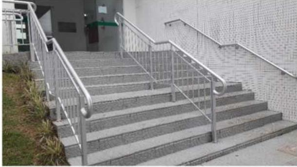
Guarda Corpo e Corrimão foram instalados e adaptados conforme as regras estabelecidas pelo Corpo de Bombeiros.
