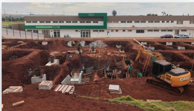
Concretagem e desforma de blocos. – 27/07/2020
