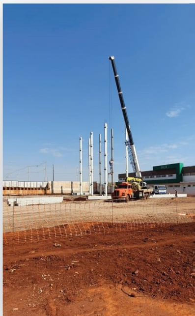
Montagem de pré-fabricados de concreto – 01/09/2020
