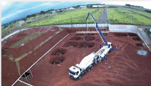
Concretagem de blocos de fundação – 22/05/2020
