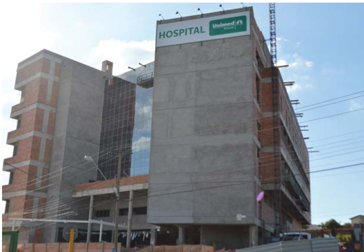
Fachada do Hospital Unidade II, já em fase de acabamento
