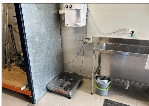
Figura 39: Balança localizada na área de manutenção para pesagem dos resíduos orgânicos, rejeitos e recicláveis.
