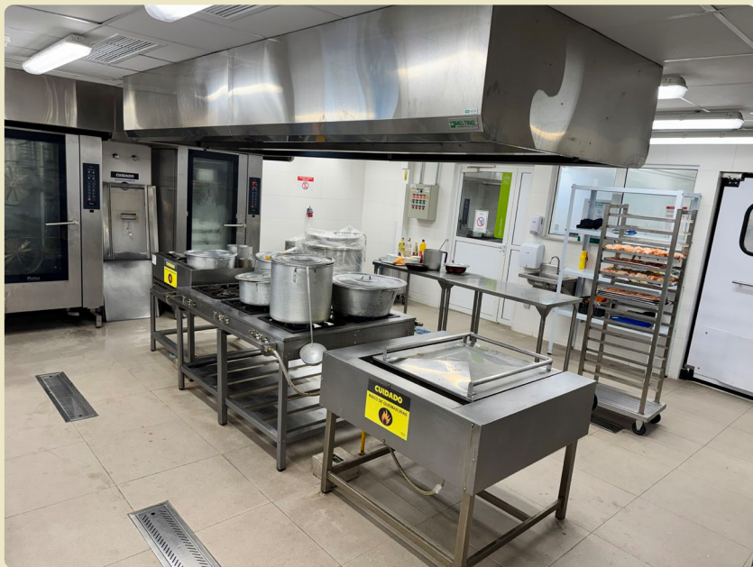
NOVAS INSTALAÇÕES DA COZINHA DO HOSPITAL UNIMED
