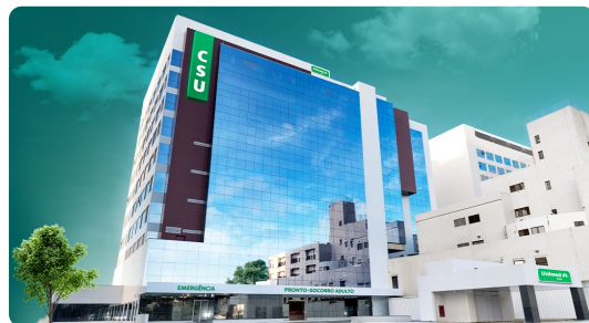
AMPLIAÇÃO DO HOSPITAL UNIMED | COMPLEXO DE SAÚDE 14/03/2025
