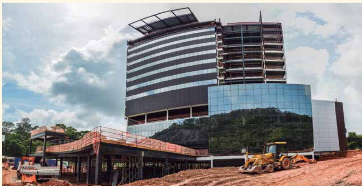
Obras do recurso próprio mineiro estão em ritmo acelerado
