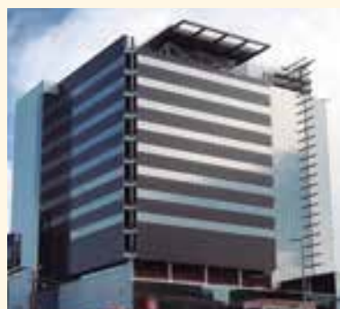
Hospital em construção
