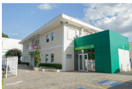
Unidade CAC2 Avenida Nove de Julho, 222
