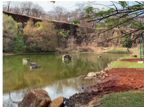
Remoção de lodo e barro da calha da lagoa
