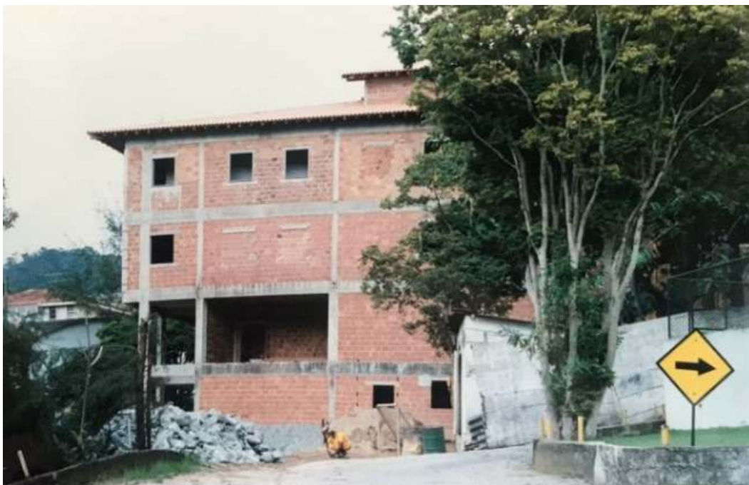
Obras no Hospital - fotos da construção do novo prédio, no período de 2001 a 2002.
