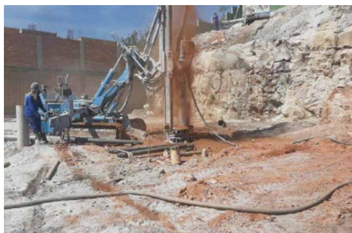
5) Abertura das Valas para Execução dos Blocos Platô A
