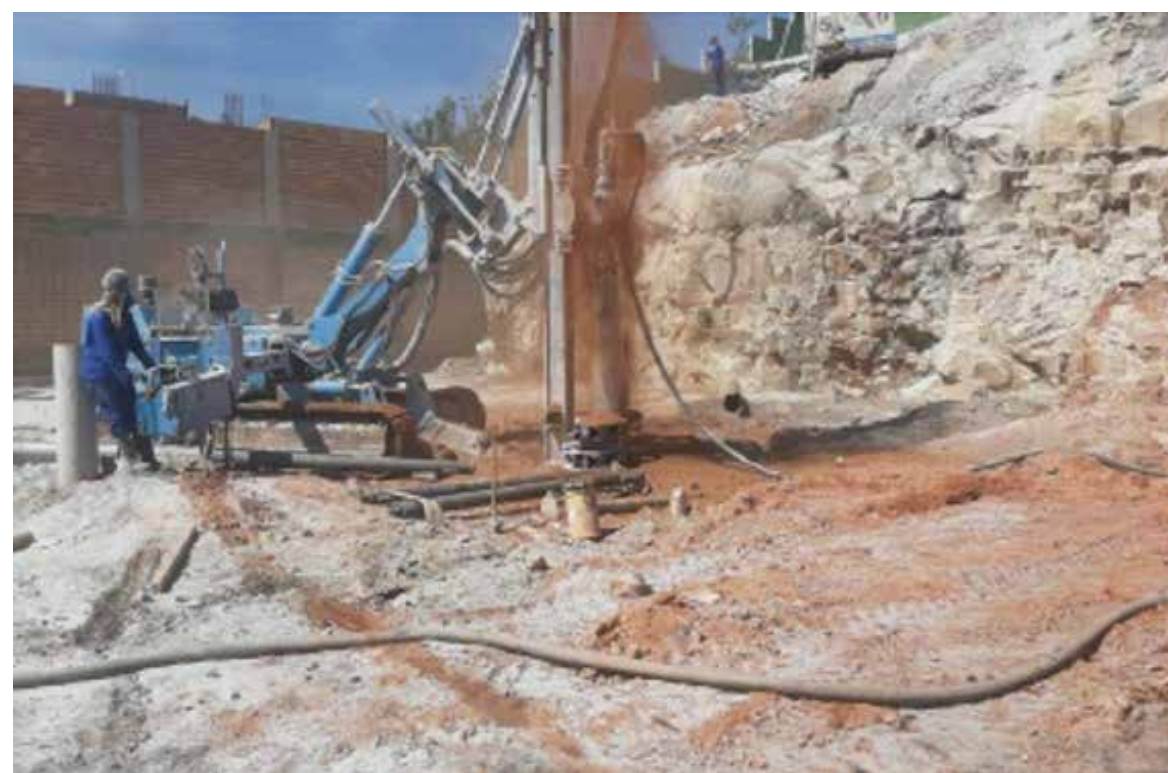
2) Execução da Fundação
