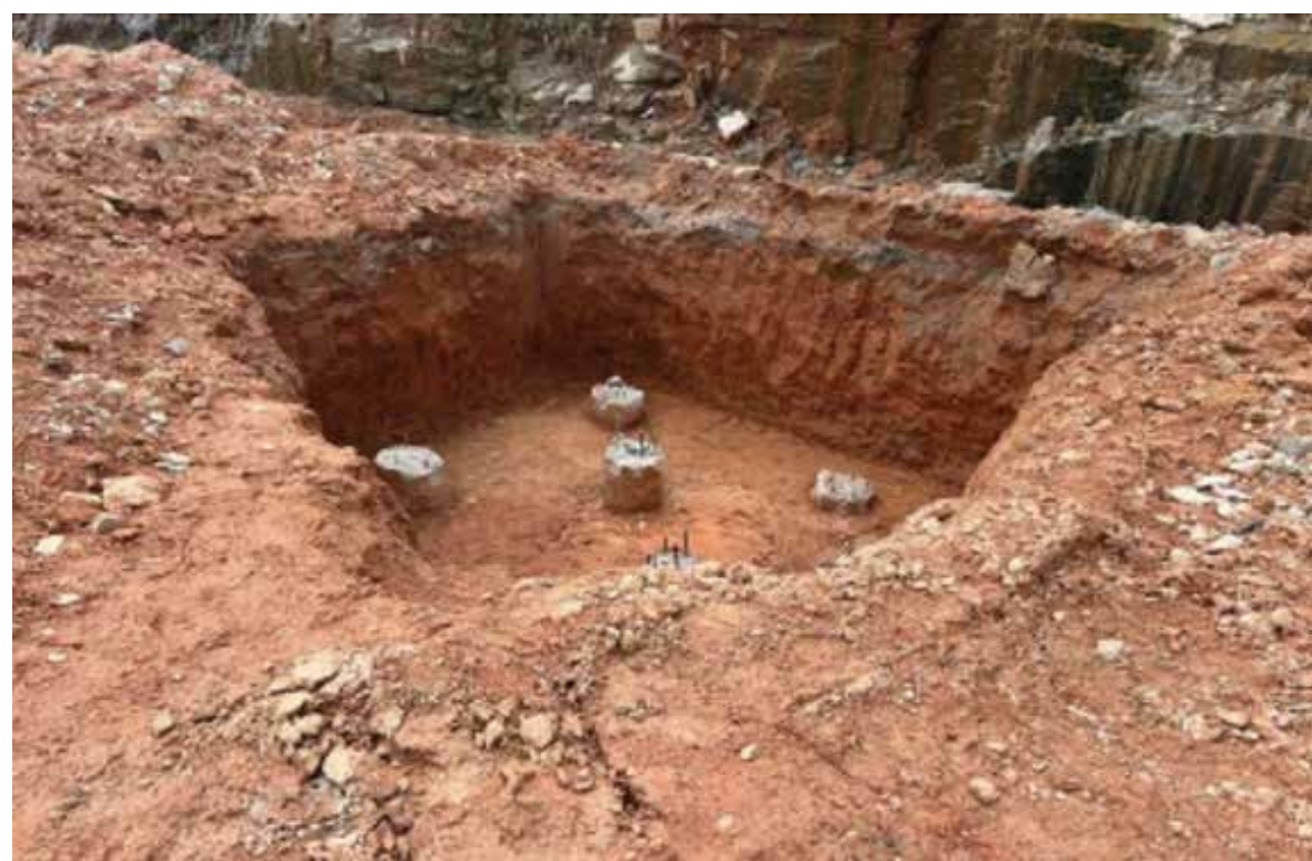
1) Arrasamento das Cabeças de Estaca nos Blocos Abertos
