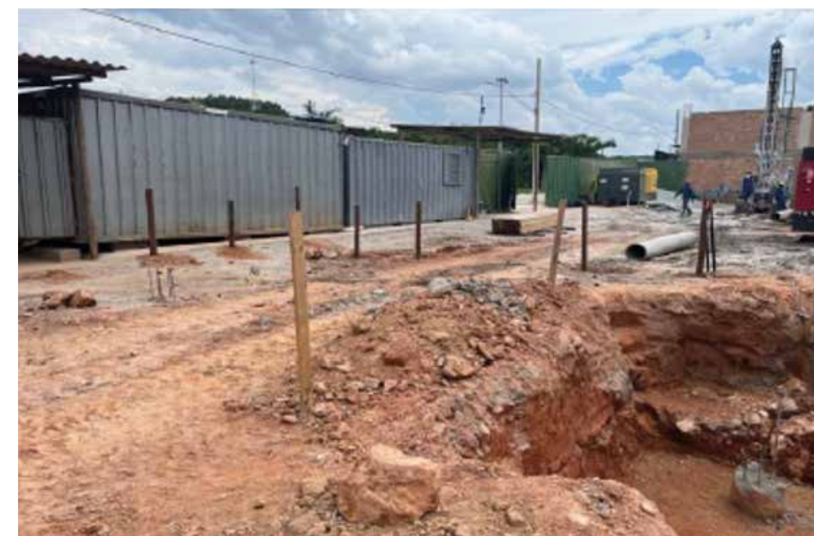
3) Execução do Gabarito para Locação da Obra
