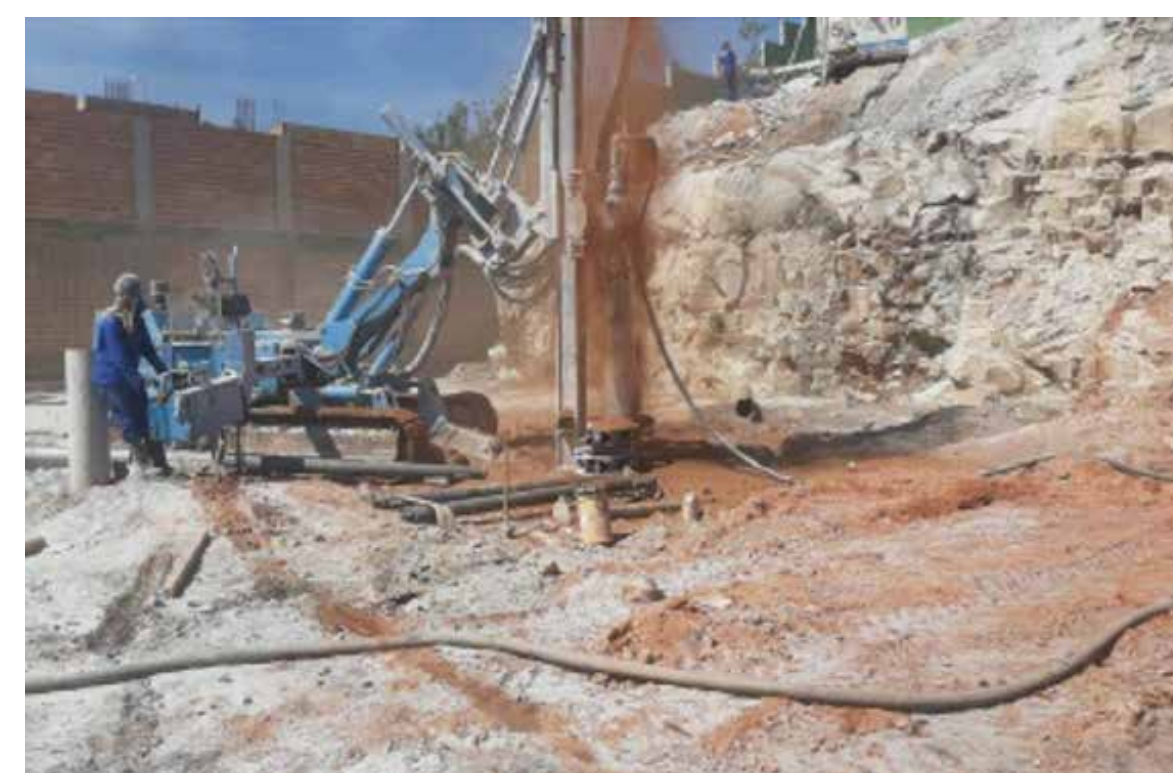
6) Locação de Estacas pela Topografia e Locação dos Eixos dos Pilares no Gabarito da Obra
