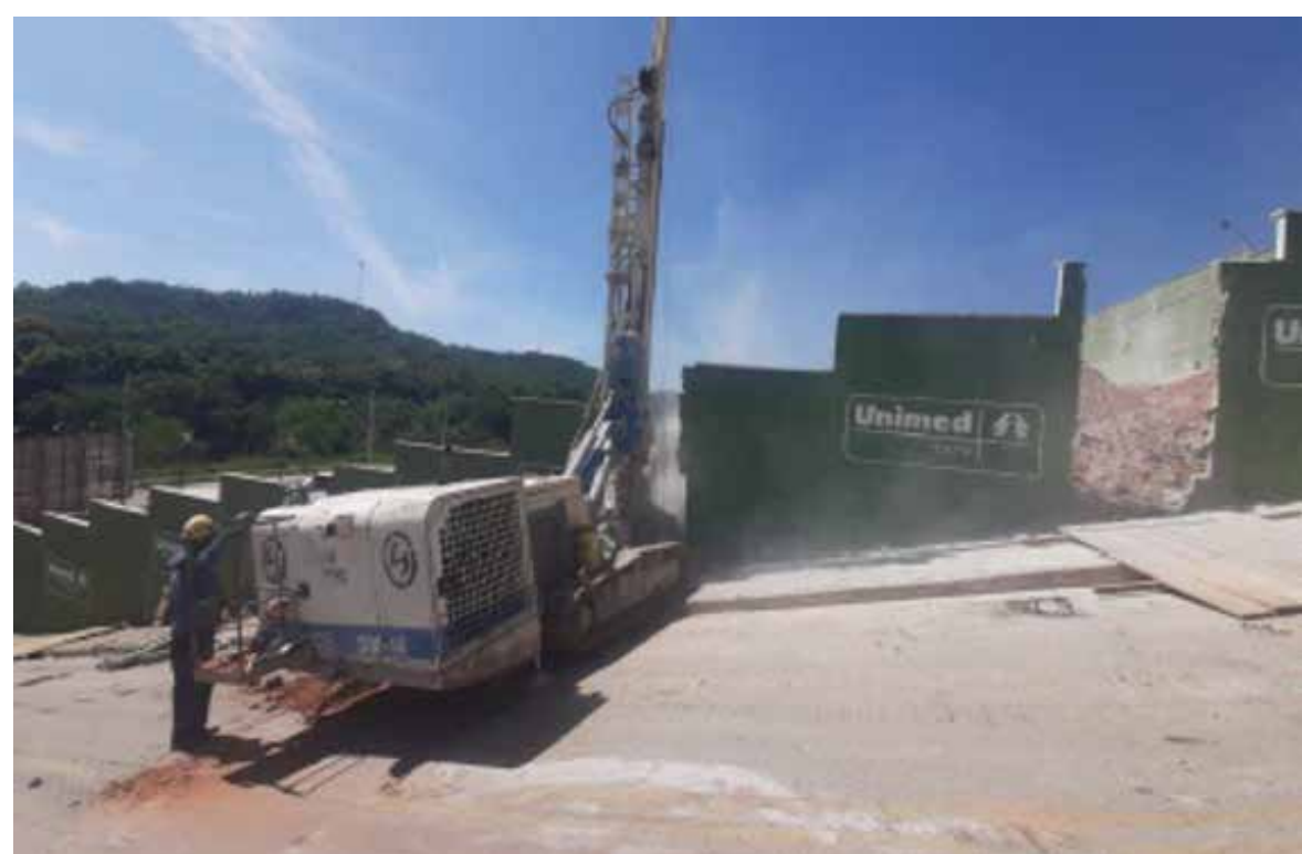
4) Abertura de Trechos no Muro Lateral para Execução de Estacas que estão no Alinhamento do Muro
