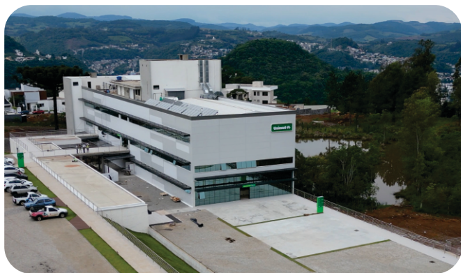
Hospital Unimed Meio Oeste - SC Rua José Firmo Bernardi, nº 868, Flor da Serra - Joaçaba/SC
