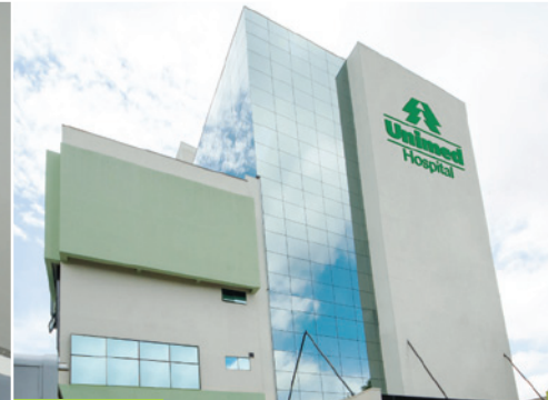
Hospital Conclusão da ampliação
